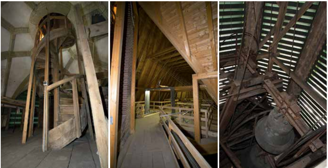
Treppenaufgang im Turm – Für die Aufhängung der Lampen wurde eine neue Ebene im Dachstuhl eingebaut – Blick auf die Glocken
